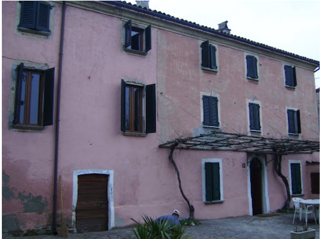
Ristrutturazione - montaggio con cardine a muro
