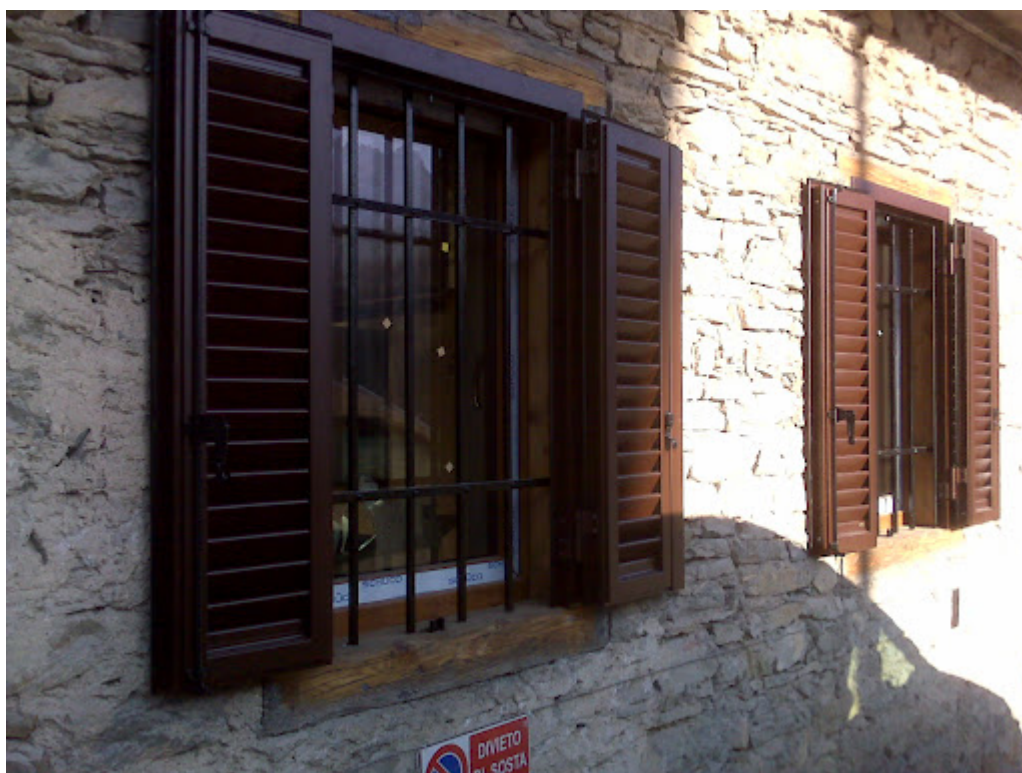
Ristrutturazione - montaggio su telaio in legno esistente
